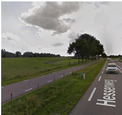
De dijk bij deeltraject 13 met de Hessenweg en vrijliggend fietspad. De dijk ligt dicht tegen het fietspad. (Beeld: Google maps)
