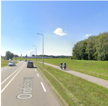
De dijk bij deeltraject 15 met de doorgaande weg en vrijliggend fietspad. De dijk ligt dicht tegen het fietspad. (Beeld: Google maps)
