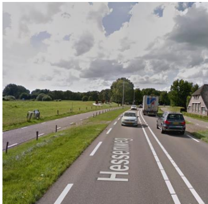
De dijk bij deeltraject 14 met de Hessenweg en vrijliggend fietspad. De dijk ligt dicht tegen het fietspad. (Beeld: Google maps)
