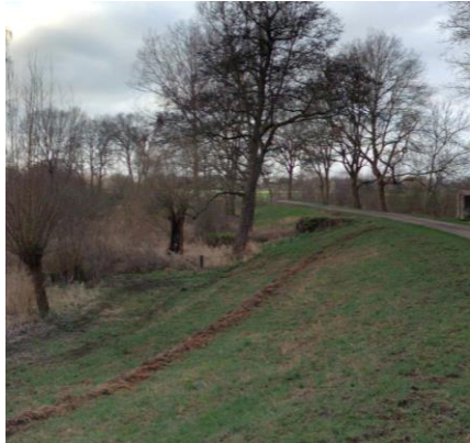
Beeld van de dijk rondom natuurgebied de Zijlkolk, met hierop zichtbaar het fietspad dat op de dijk ligt. (Beeld: Streetsmart Cyclomedia)
