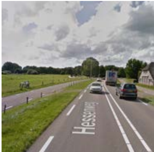
De dijk bij deeltraject 14 met de Hessenweg en vrijliggend fietspad. De dijk ligt dicht tegen het fietspad. (Beeld: Google maps)
