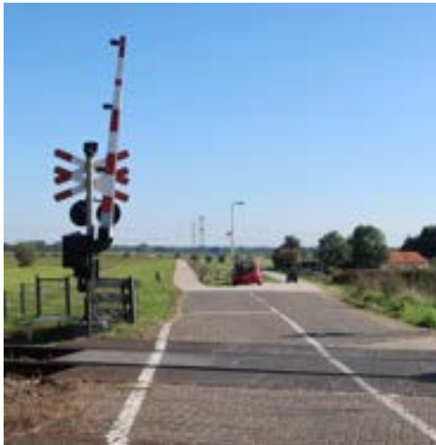
Beeld van de dijk t.h.v. de spoorwegovergang in de Maatgravenweg.
