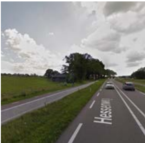
De dijk bij deeltraject 12 met de Hessenweg en vrijliggend fietspad. De dijk ligt dicht tegen het fietspad. (Beeld: Google maps)
