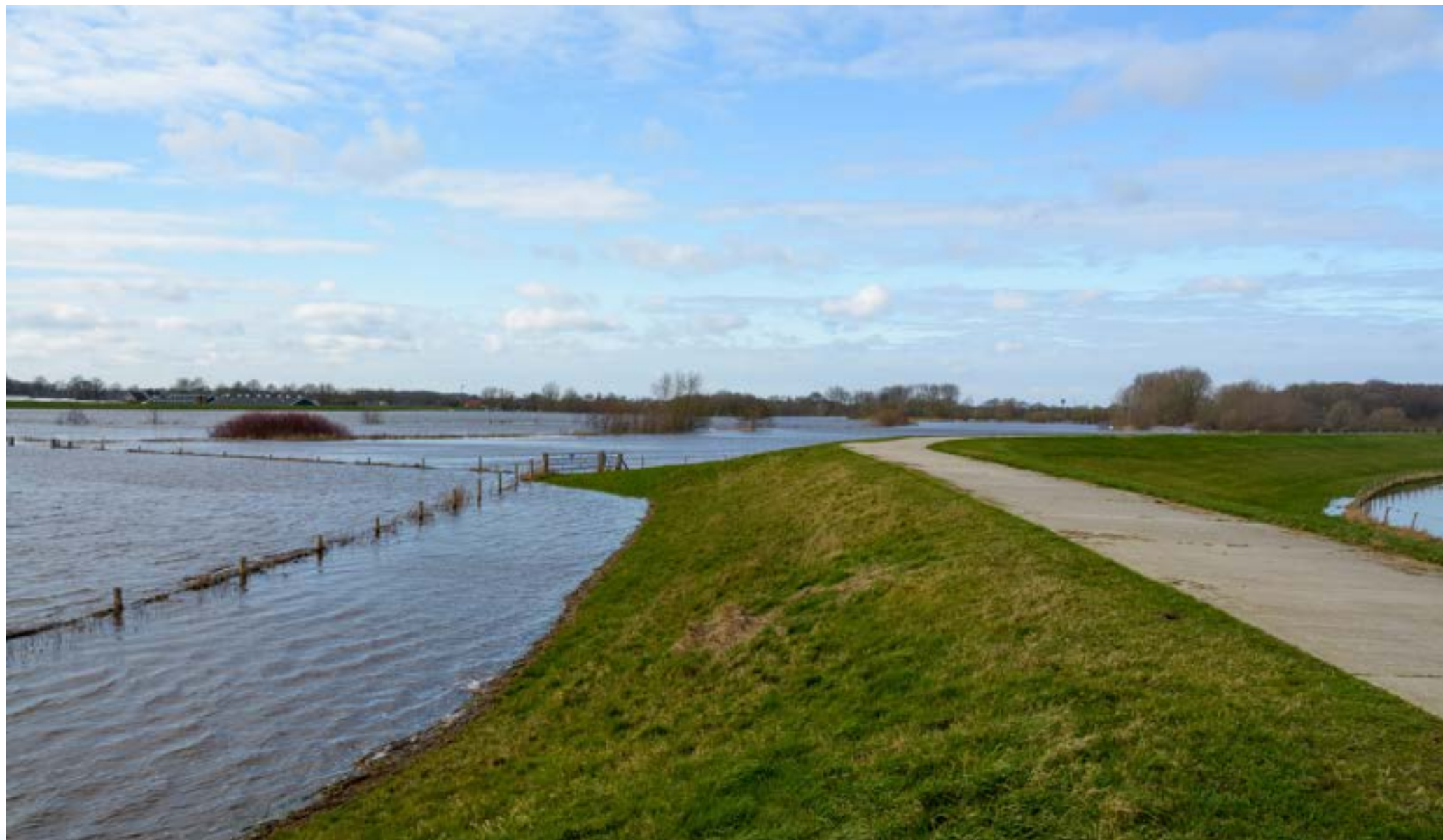
Figuur 4-15 Foto van hoog water in de Vecht nabij De Stokte in februari 2022
