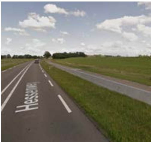
De dijk bij deeltraject 11 met de Hessenweg en vrijliggend fietspad. De dijk ligt dicht tegen het fietspad. (Beeld: Google maps)
