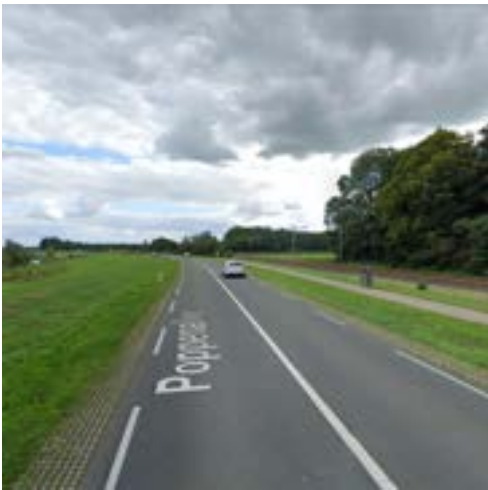
Impressie van de infrastructuur in deeltraject 2, met weg, fietspad en spoorlijn naast elkaar. (Beeld: Google Maps)
