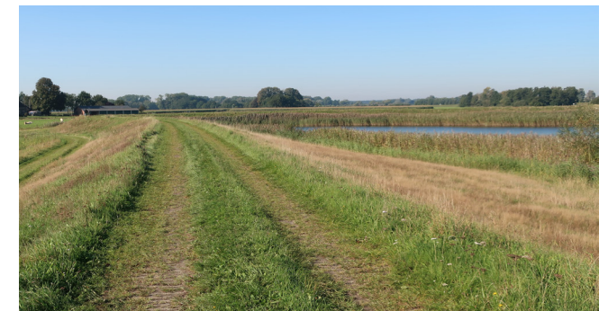
Een kolk nabij Langenholte, na een dijkdoorbraak is deze kolk ontstaan en de dijk om de kolk heen gelegd.
