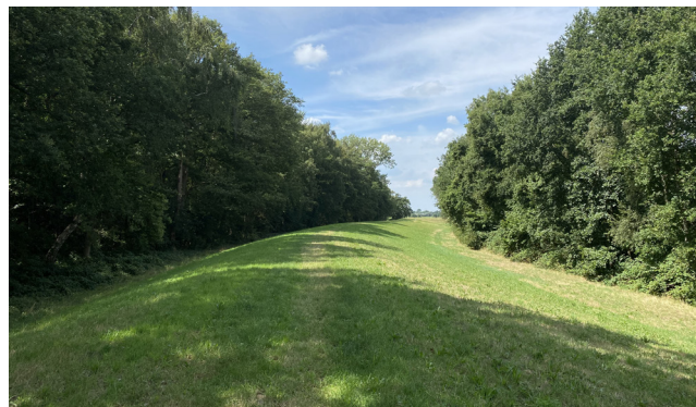
1. Veelvoorkomend zanddijk profiel: de vierkante dijk met vierkante kruin
