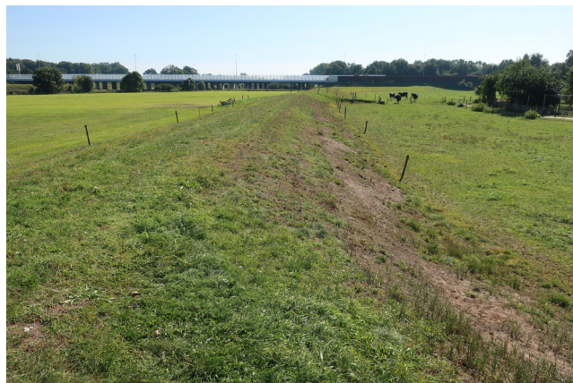
Op sommige plekken is het goed te zien dat het een zanddijk is.
